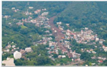
R3.7 静岡県熱海市 死者28名、住宅被害99棟
