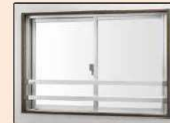
転落防止の手すりの設置
